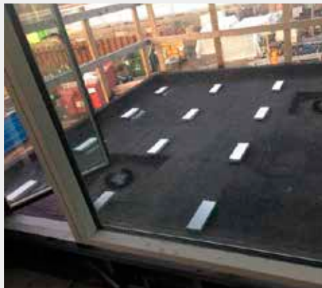
PWT kassetterne monteres på tagpappet i forhold til befæstelsen af underpappet og strørernes placering.
